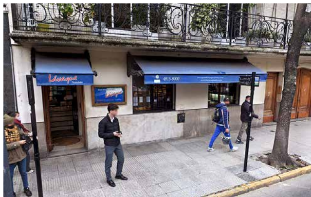
Antigua oficina de la calle Montevideo 1318.
